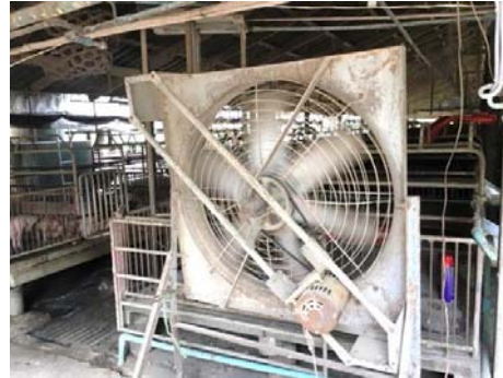
รูปที่ 1.8 แหล่งกำเนิดเสียงจากพัดลมระบายอากาศในโรงเรือน
