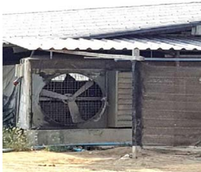
รูปที่ 1.8 แหล่งกำเนิดเสียงจากพัดลมระบายอากาศในโรงเรือน
