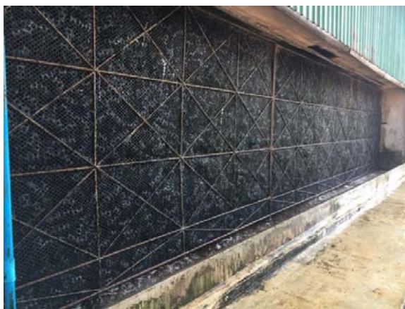
รูปที่ 2.5 ระบบสครับเบอร์ทางชีวภาพ
