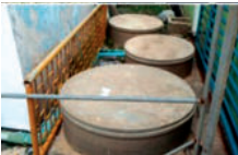
(ก) บ่อเกรอะ-บ่อซึม แบบวงขอบซีเมนต์
