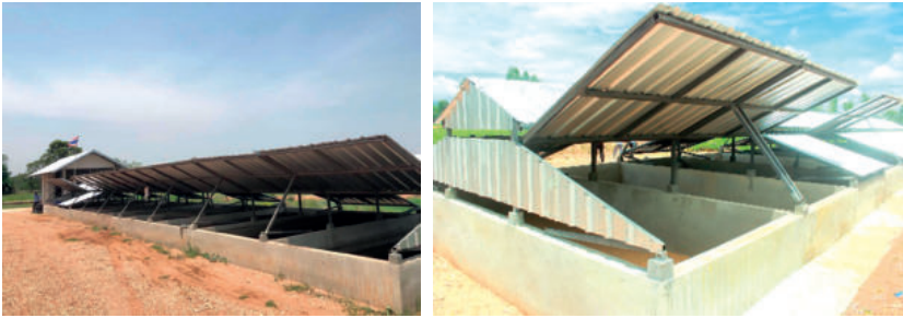
รูปที่ 5-4 ระบบลานทรายกรอง (Sand Drying Bed)
