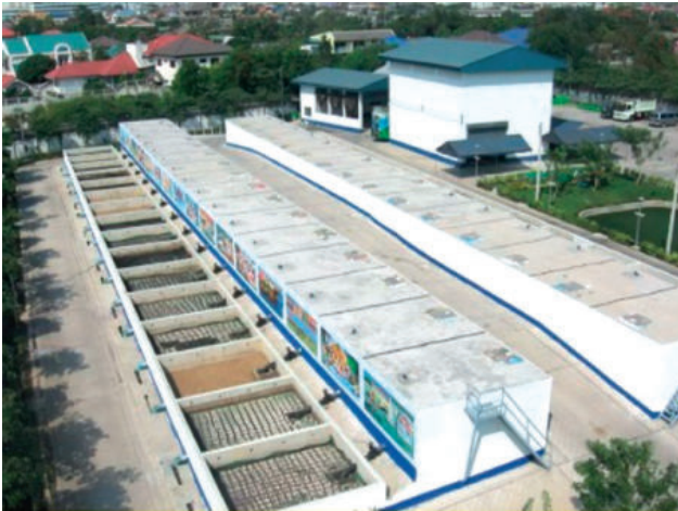
รูปที่ 5-3 ระบบถังหมักไร้อากาศ (Anaerobic Digester)
