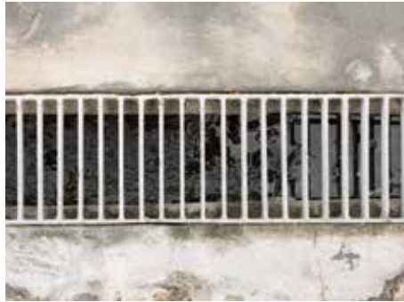
รูปที่ 45 รางระบายน้ำ
