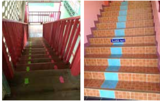
รูปที่ 10 การจัดการความปลอดภัยกับบันไดอาคาร
