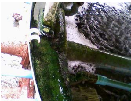
รูปที่ 17 แสดงลักษณะการเกิดตะไคร่น้ำ ในหอผึ่งเย็น ซึ่งเป็นแหล่งเพาะ เชื้อลีสทีโอเนลลา
