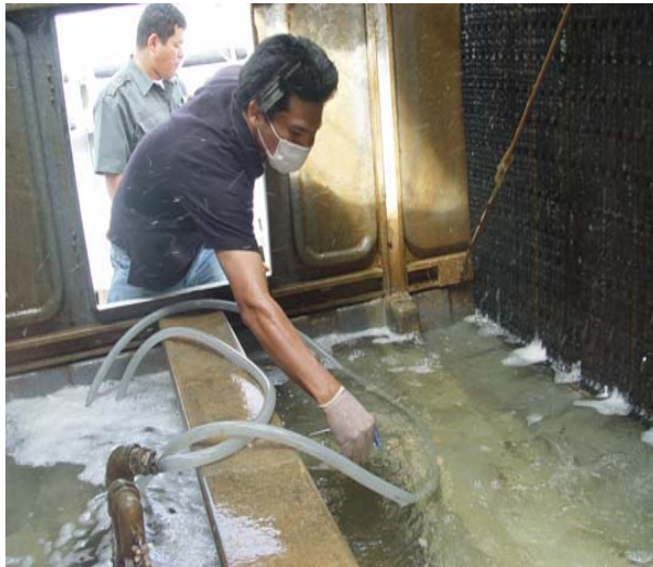
รูปที่ 12 แสดงการเก็บตัวอย่างน้ำเพื่อวิเคราะห์หาเชื้อลิจิโอนัลลา ที่บริเวณถังพักน้ำ (Basin) ในหอผึ่งเย็น
