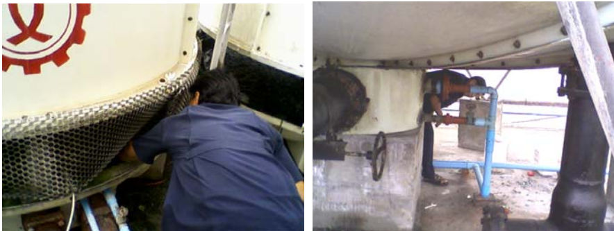
รูปที่ 19 แสดงการตรวจตรา ซ่อมบำรุงหอผึ่งเย็น
