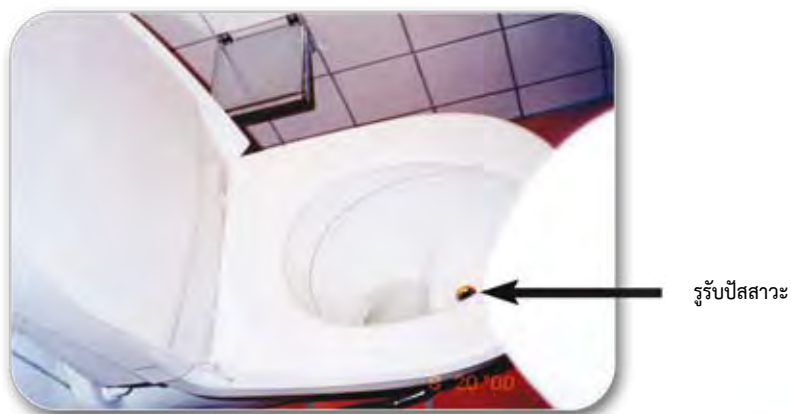
รูปที่ 3 - 7 โถส้วมแยกปัสสาวะแบบใช้น้ำ ชนิดนั่งราบ
