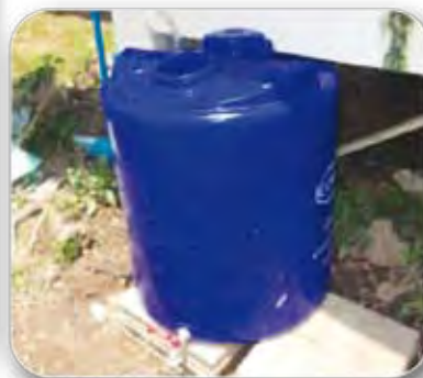
รูปที่ 3 - 18 ส่วนแยกปัสสาวะนั่งของแบบใช้น้ำ ศูนย์ 3 วัย จ.แพร่
