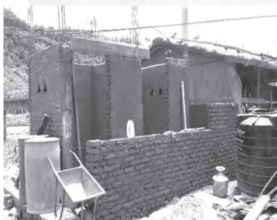
ภาพที่ 7 แสดงความคืบหน้าในการก่อสร้างตัวเรือนและงานฉาบผนังส้วมขณะที่ยังอยู่ที่หน่วยที่ 6 ปฏิบัติงานในประเทศเนปาล
