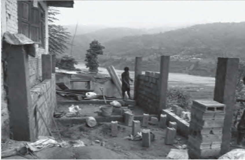
ภาพที่ 13 เริ่มก่อสร้างใหม่
